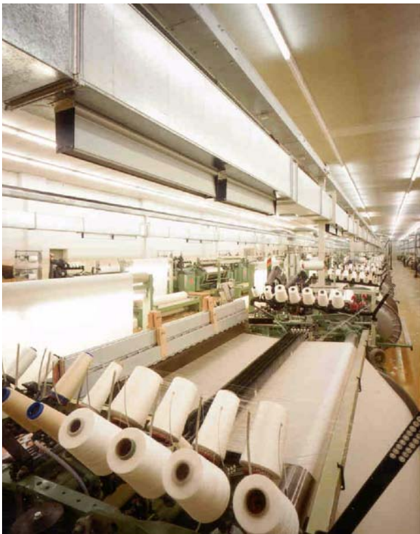
LTG weave direct System, Einsatz über dem Webstuhl
