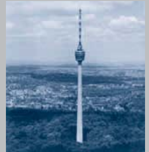
Der 1. Fernsehturm der Welt in Stahlbeton-Bauweise wurde in Stuttgart gebaut. Schon damals war die LTG als Partner dabei.
