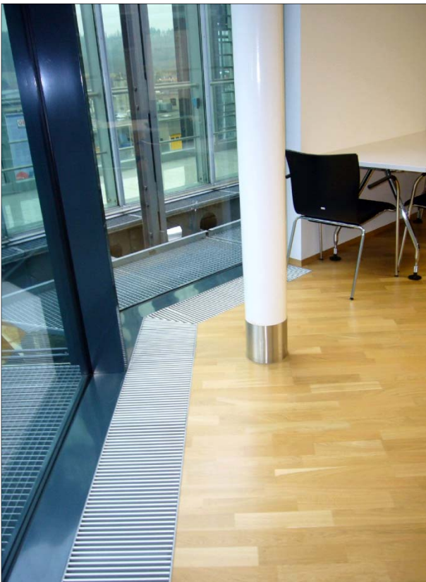
Einbaubeispiel, mit LTG Aluminium-Rollrost
