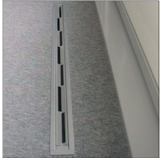
Einbaubeispiel Boden-Luftdurchlass Typ LDU 30/1/...,
