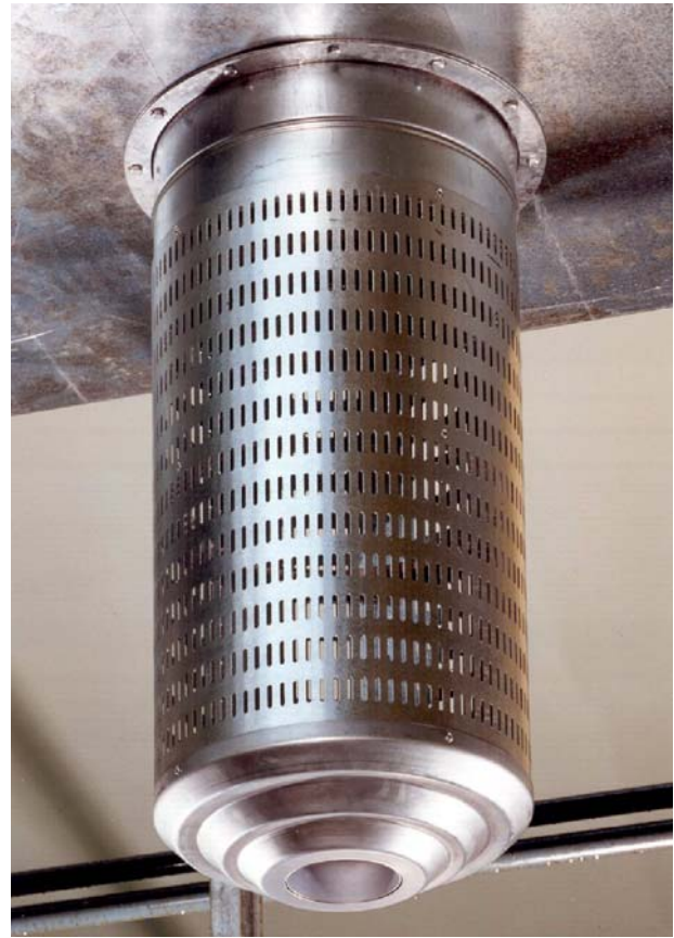
Industrie-Luftauslass Typ DLD mit Düsenverkleidung
