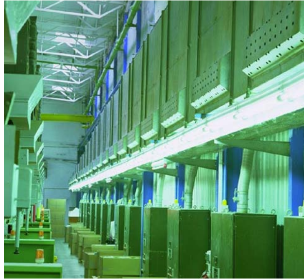
Luftauslässe Typ LTB, direkt an den Zuluftkanal angebaut, Lufteinblasung von der Seite.
