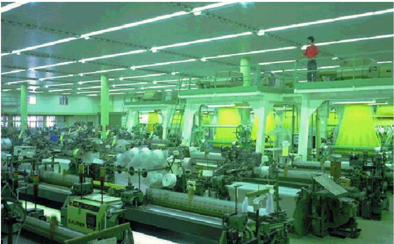
Luftauslässe Typ LTB, in die Zwischendecke eingebaut, Lufteinblasung von oben.
