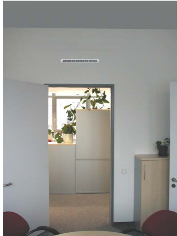
Einbaubeispiel Überström-Luftdurchlass Typ LDO-T
