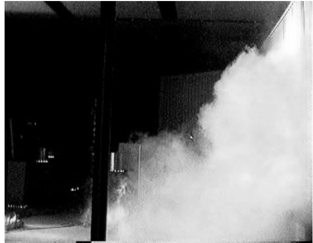
LTG Raumströmungstechnik: zugfreie Misch-/ Quellströmung durch abgestimmten Fächereinsatz
